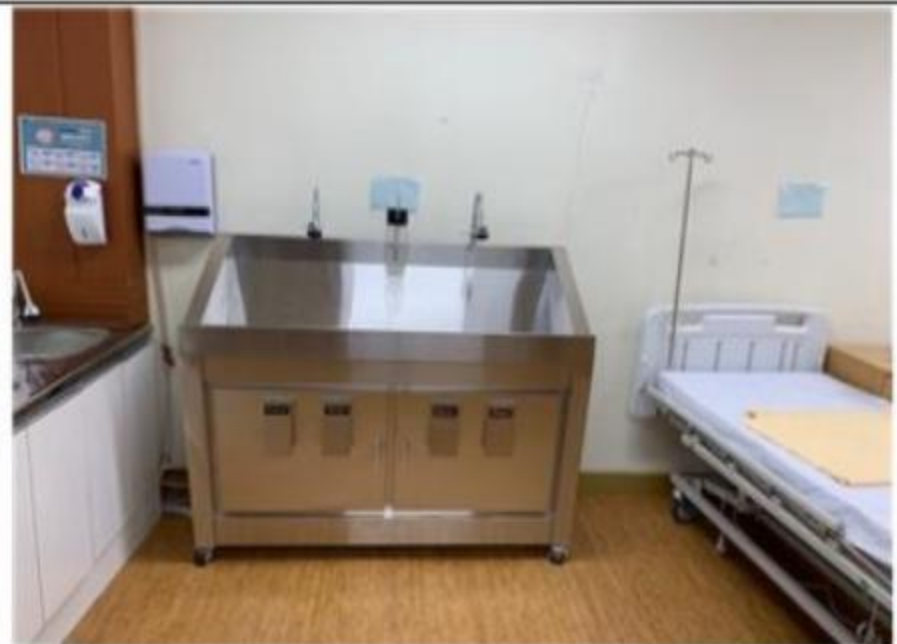
자율실습실2 외과적 손씻기용 스크럽대 설치
